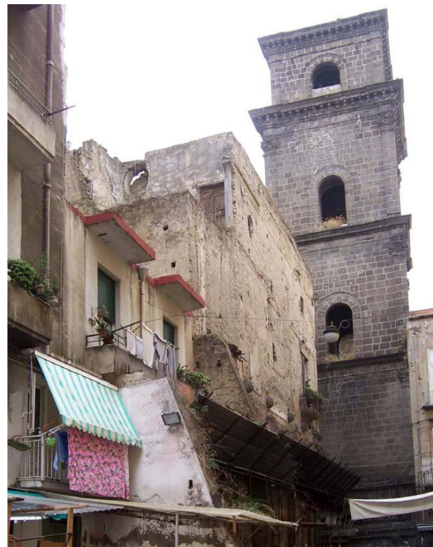
Fig. 6: Vico Maffei, il rudere dell'edificio d'angolo
